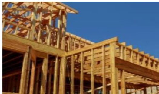
Figura 30. Estructura en madera.
