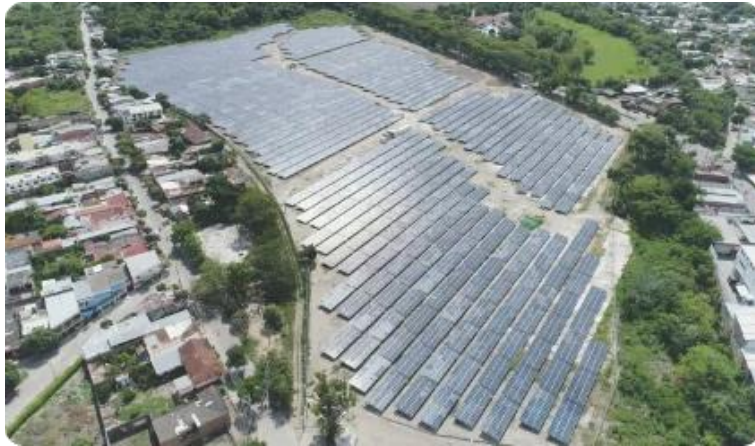
Figura 76 Granja Celsia Solar Carmelo, Valle del Cauca. Fuente: (Celsia, 2021).
