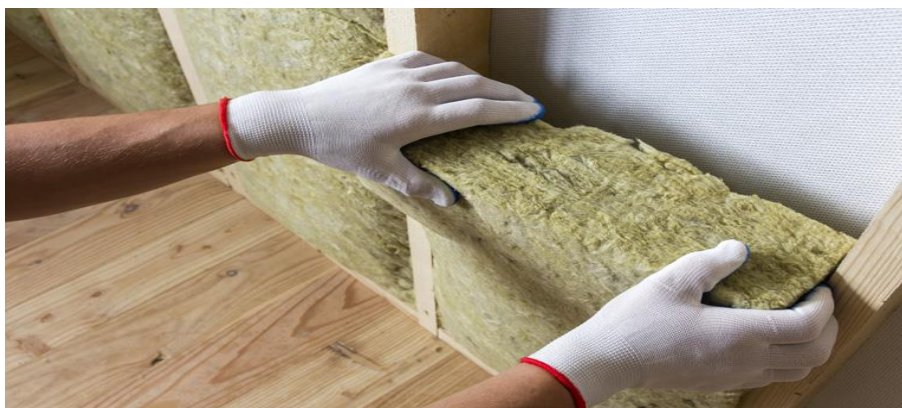
Figura 64 Acondicionamiento térmico Fuente: PDAO 2023.
