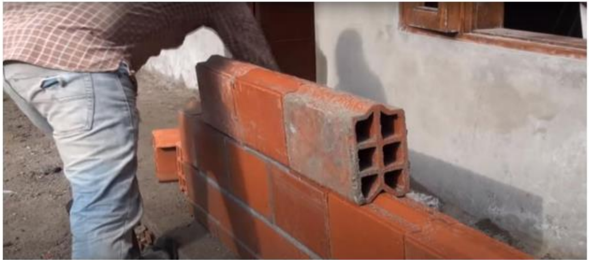
Figura 14. Proceso constructivo empresa PCA
