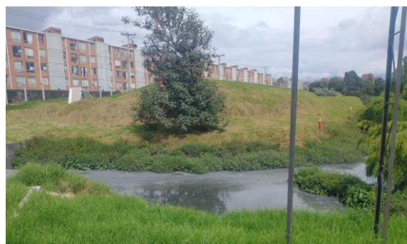
Imagen 8 Parte del Humedal de Techo
