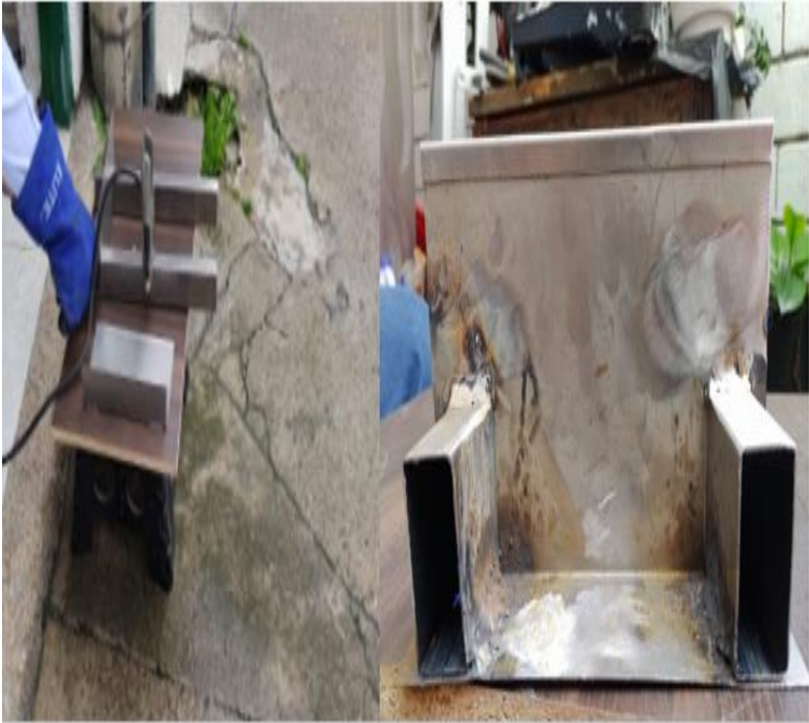
IMAGEN 48 PROCESO DE SOLDADURA. ALFONSO. CASTAÑEDA. 2022
