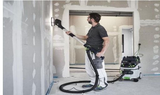
Figura 4 Proceso de lijado de masilla en Drywall. Imagen tomada de (Adrián, 2022)
