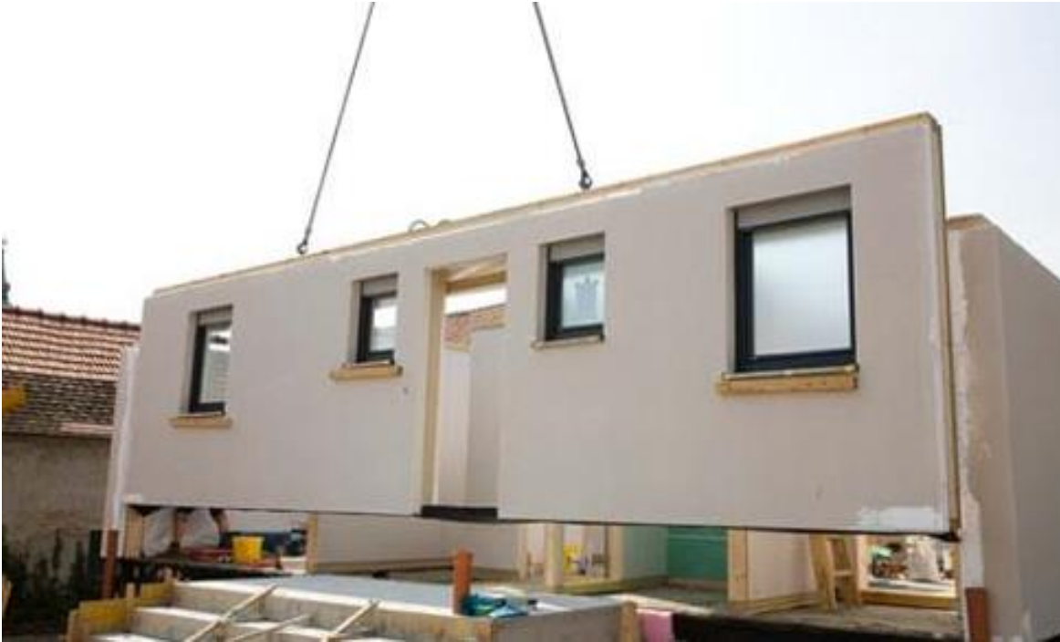
Ilustración 23. Construcción modular. 2019 Fuente. https://www.en-obra.com/noticias/construccion-modular-en-sistemas-prefabricados
