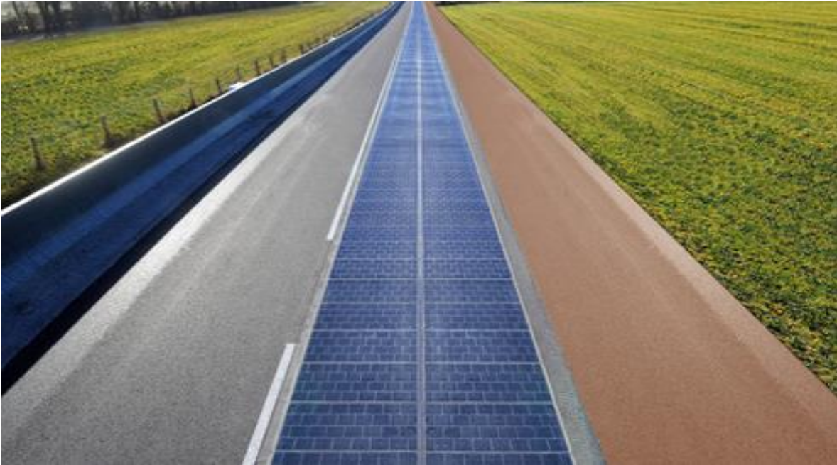
Ilustración 26. pavimento deteriorado, ruidoso y poco eficiente. 2019 Fuente. https://www.xataka.com/energia/primer-experimento-carretera-solar-francia-ha-sido-fracaso-pavimento-deteriorado-ruidoso-poco-eficiente
