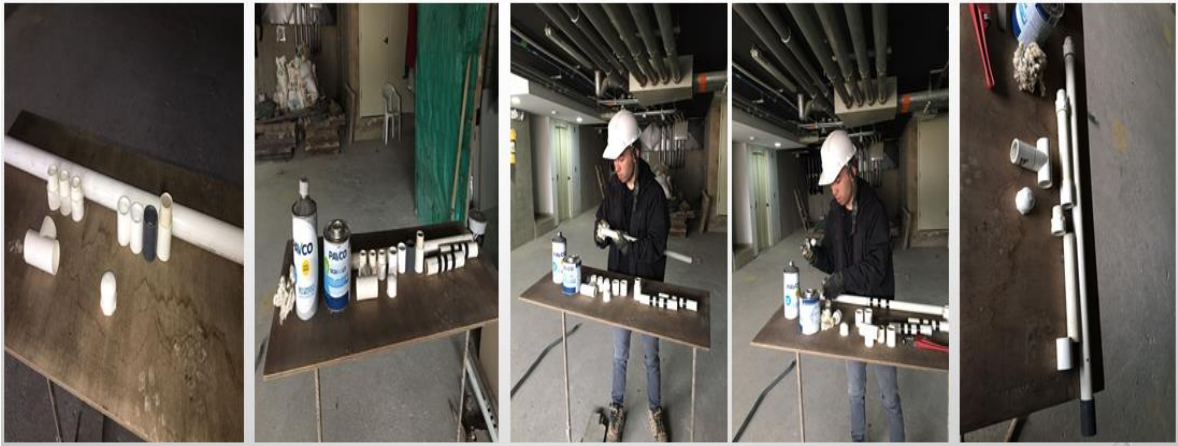
Paso 3. Resane y Anticorrosivo
