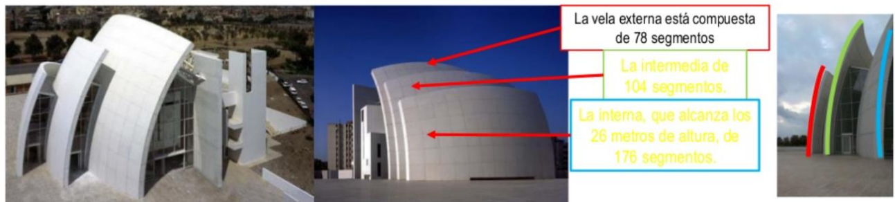
Figura 27 IGLESIA DE JUBILEO ROMA. Fuente Giannotti, A. (2019, 24 octubre). Iglesia del 2000 / Richard Meier & Partners. ArchDaily Colombia. abril 15 de 2021
