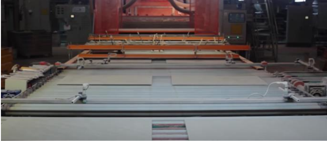
Figura 32 maquinaria baldosa, Fuente: Dombrowski, R. (2019, 2 febrero). Cadena de producción con las baldosas cerámicas. Dreamstime.com. abril 15 de 2021
