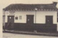
Casa Colonial del General Cesario Pulido Calle 8 Carrera 16.
