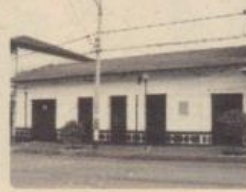
Casa Colonial del Capitán Carlos Lee Calle 8 Carrera 19.
