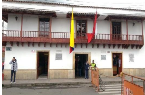
Imagen 11. Fachada Palacio Municipal.
