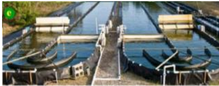
Figura 6: Instalación comercial de Cyanotech Corporation 4 Biorreactor abierto, cuenta con lagunas con capas de plástico que cubren el espacio y aspas giratorias para ejercer agitación en el cultivo.
