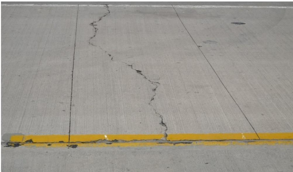
*Ilustración 14 Fisuración Trasversal Fuente: (Cervantes 2016)*
