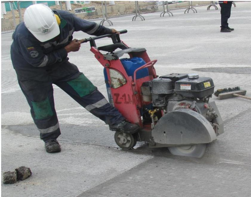
*Ilustración 4 Proceso de Corte losa de concreto fuente: Propia*
