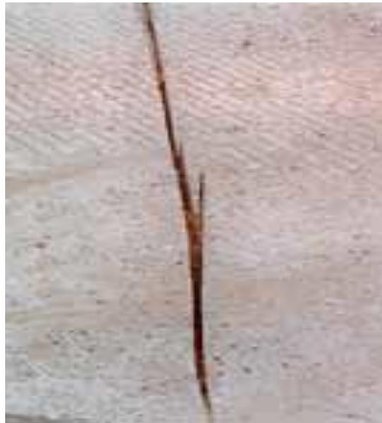
*Ilustración 26 Desviaciones en el corte de la junta Fuente: Euclid Chemical Toxement*
