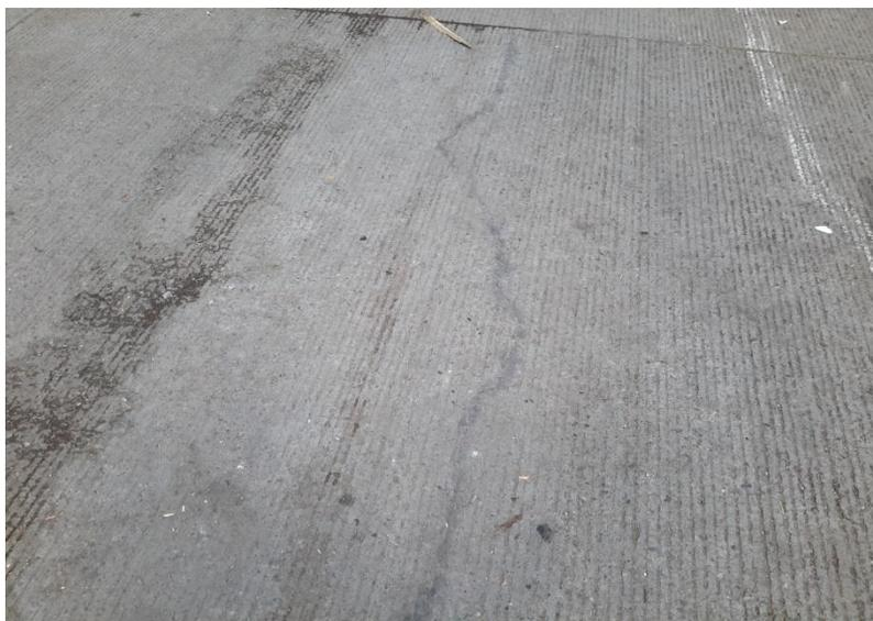
*Ilustración 7 Deterioro en Pavimentos Rígidos Fuente: Propia*
