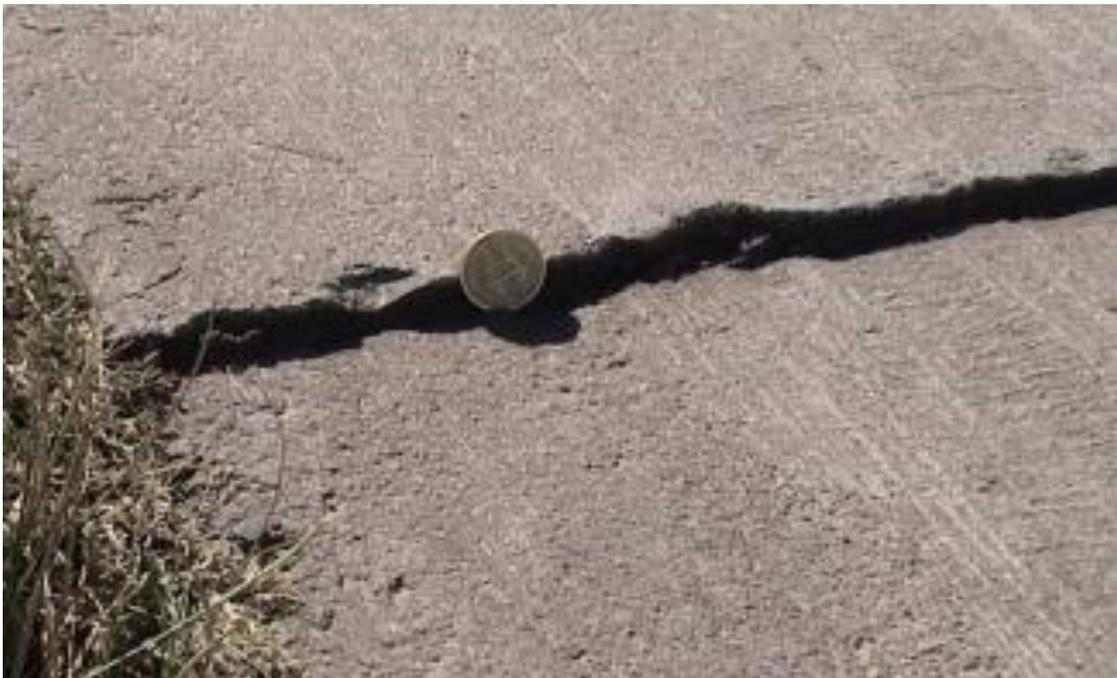
*Ilustración 21 Deterioro total efecto bombeo y escalonamiento Fuente ICPA 2010*
