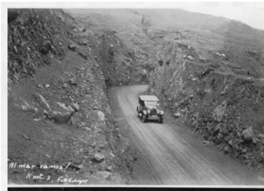
*Ilustración 11 (Salazar, 1928) Carretera al mar Km. 3. Obsérvese el trabajo de ingeniería, para atravesar la cordillera abriendo las montañas.*
