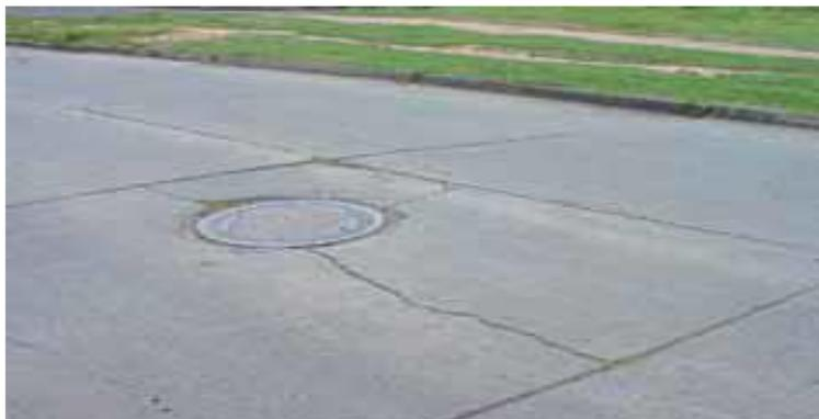
*Ilustración 24 Fisuras por falta de aislamiento del pavimento y pozo de inspección Fuente: Euclid Chemical Toxement*
