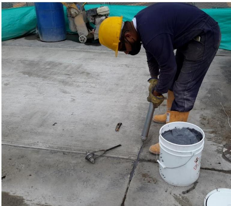
*Ilustración 27 Sellado de juntas en concreto Fuente: Propia*
