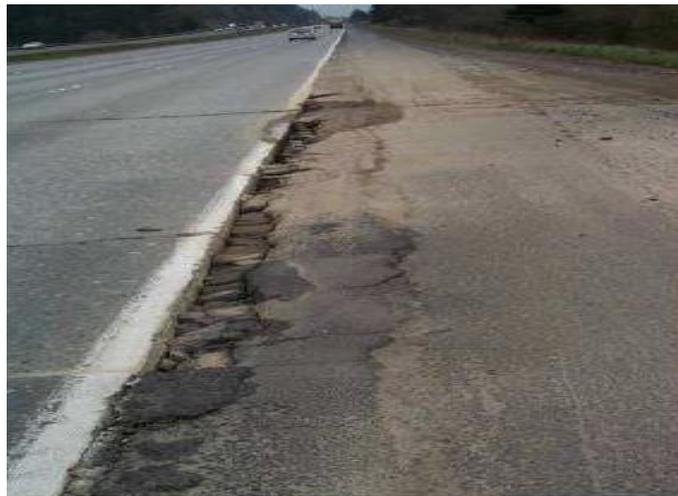
*Ilustración 15 Erosión en vía por bombeo y escalonamiento Fuente ICPA 2010*
