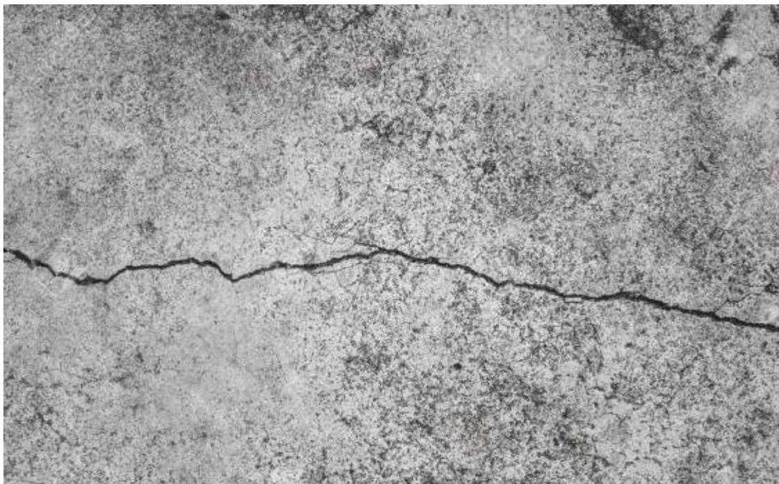
*Ilustración 22 fisura por retracción del fraguado Fuente: [www.paviconj-es.es/](http://www.paviconj-es.es/)*
