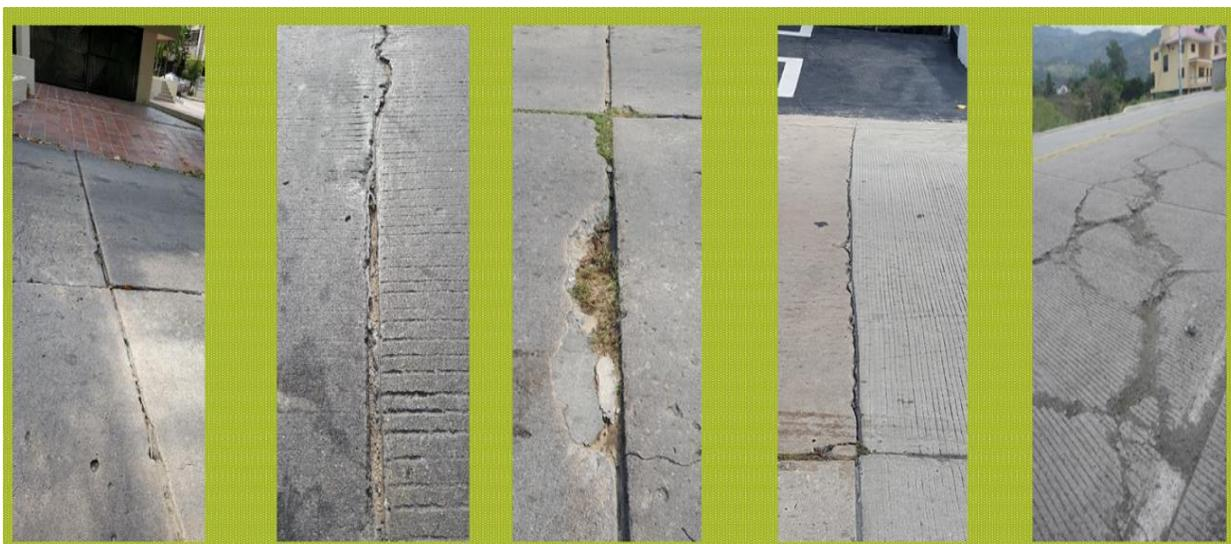
*Ilustración 13 Patologías en losas de concreto Fuente (Jimenez Rubio 2020)*
