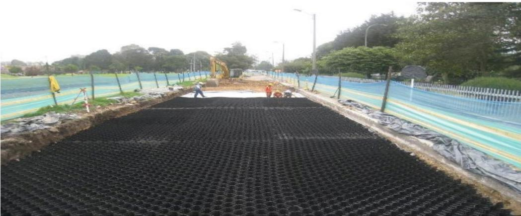
**Figura 6. Sistema de confinamiento celular. Fuente: Presentación Sistema Roadrunner Sintex.**
