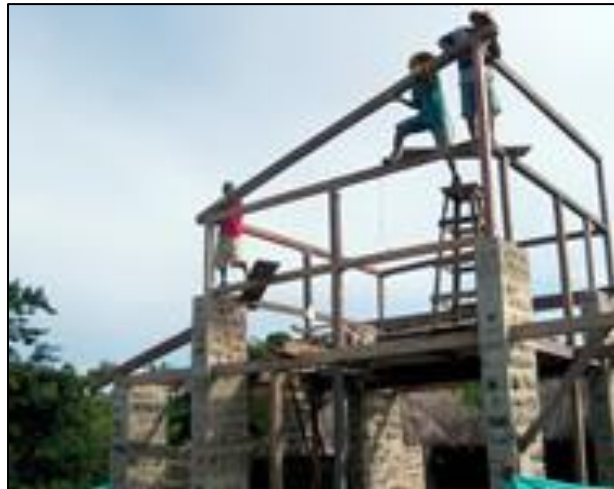
Figura 33. Construcción de Vivienda.
