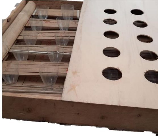
Figura 102. Ubicación de botellas PET en la estructura
