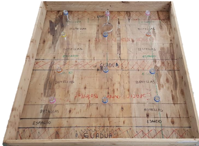
Figura 98. Armado de la Estructura
