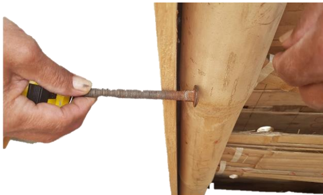
Figura 103. Anclaje de Panel
