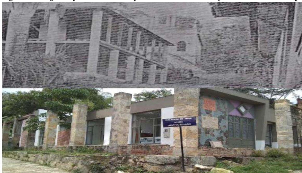
Figura 4. Antiguo edificio Fould o beneficiadero comunitario hoy Casa Social de la Mujer
