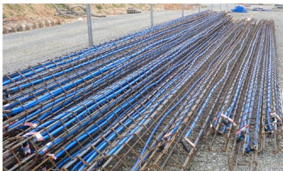
Ilustración 81. Pilotes termoactivos. Tomado de: https://www.egis-group.com/
