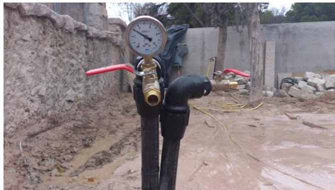
Ilustración 136. Pruebas de estanqueidad y presión. Tomado de: www.Construction21.org
