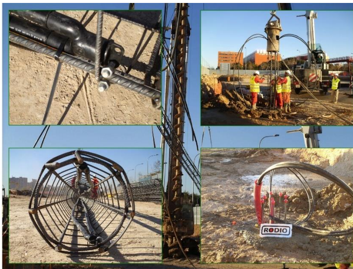
Ilustración 137. Instalación de sondas. Tomado de: https://www.eve.eus/
