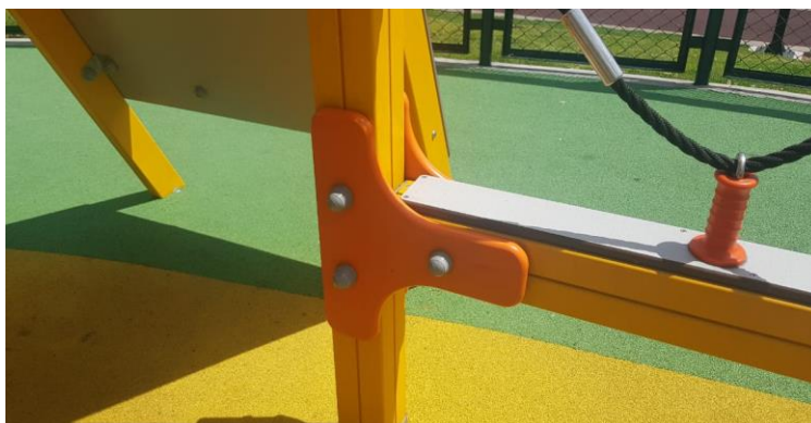
Ilustración 11 Modelo Unión viga columna, Foto Gaona, A.
