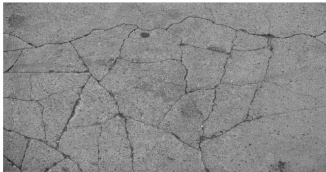
Ilustración 13. Retracción en el concreto
