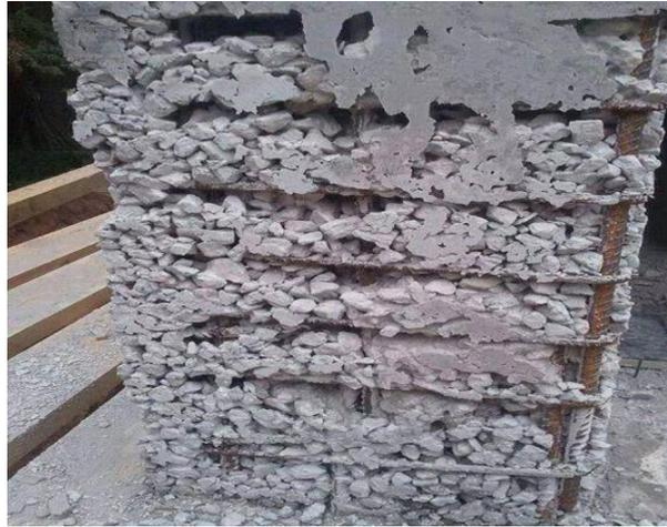
Ilustración 12. Segregación en el concreto
